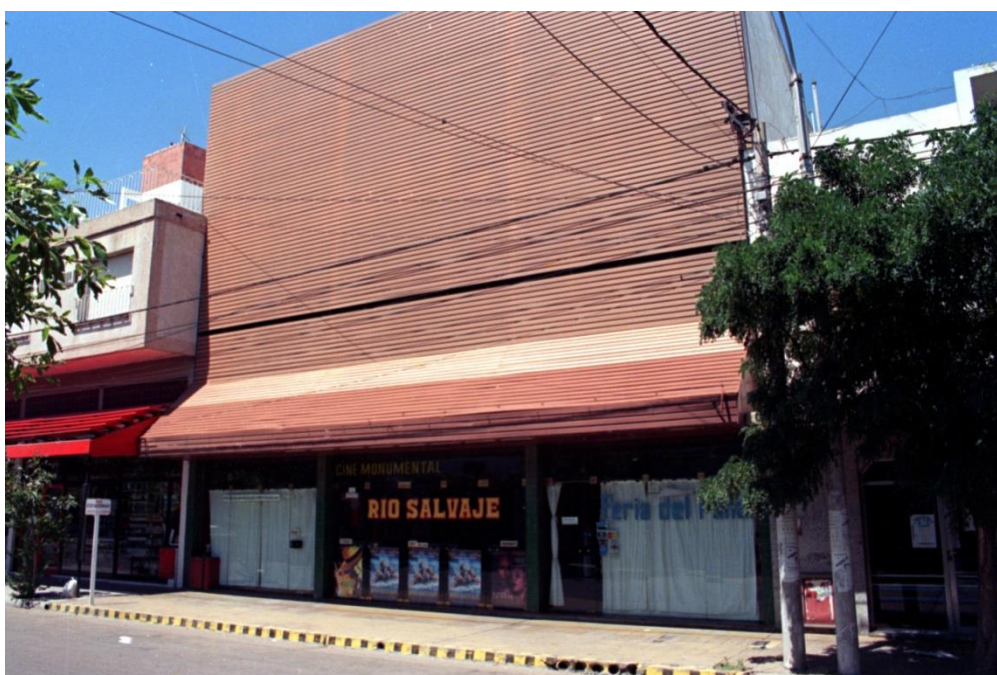
Edificio del Cine Monumental, 1995. Archivo Histórico Provincial.
