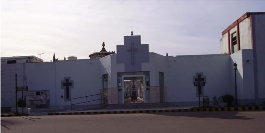
Fachada actual del ingreso al cementerio municipal de la ciudad de Santa Rosa.
